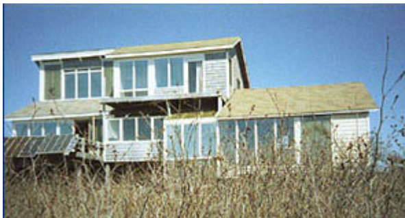
Τα μεγάλα παράθυρα και ο νότιος προσανατολισμός του κτηρίου εκμεταλλεύονται καλύτερα την ηλιακή ενέργεια
